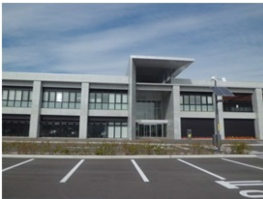
福島県環境創造センター 交流棟
