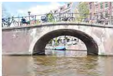
運河に直結している建築物
