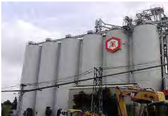
工場には立派なタンクが！
