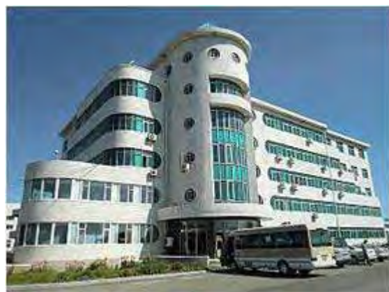
立派な下水処理場管理棟
