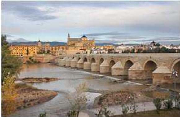
ローマ橋 左側
