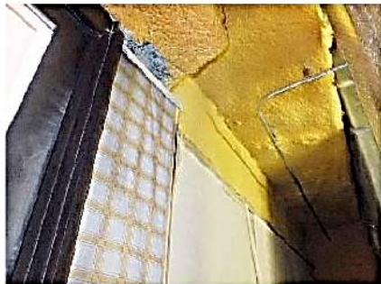
吹付けパーミキュライトに被膜工法
