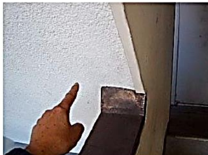
吹付け石綿の上に吹付けロックウール施工
