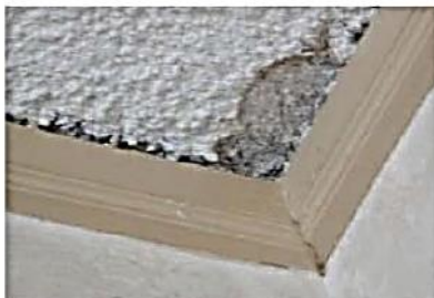
吹付け石綿の上に吹付けパーライト
