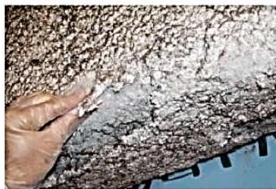
吹付け石綿の上に吹付けパーライト
