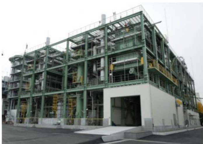
固形燃料化施設（新河岸川水循環センター）
